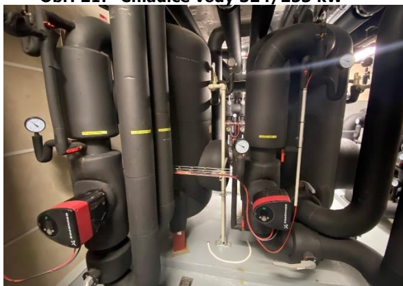
Obr. 23: Akumulační nádrže chlazení
