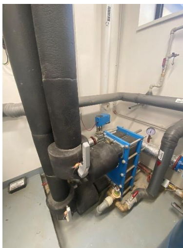
Obr. 12: Výměník předehřevu TV z chlazení
