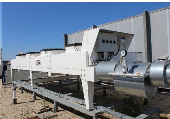
Obr. 20: Suchý chladič 335 kW
