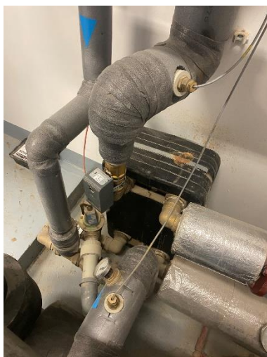
Obr. 11: Výměník pro ohřev TV
