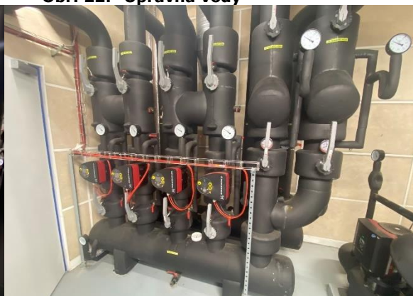
Obr. 24: R+S chlazení
