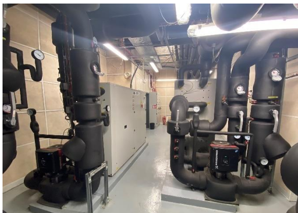
Obr. 21: Chladiče vody 324/253 kW
