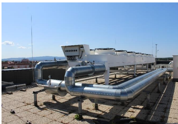
Obr. 19: Suchý chladič 413 kW
