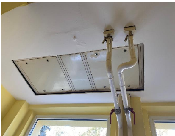
Obr. 17: Podstropní jednotka
