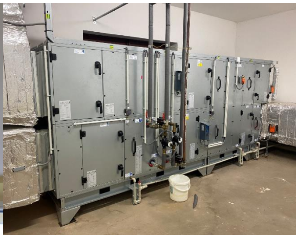
Obr. 18: VZT jednotka pro Endosály
